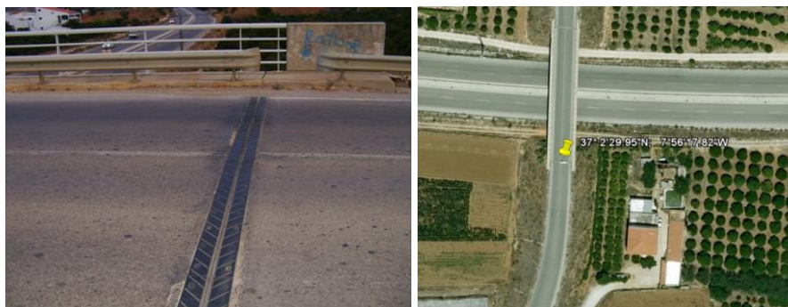
Figura 4 – Apontamento fotográfico da Junta 2 e sua localização geográfica
