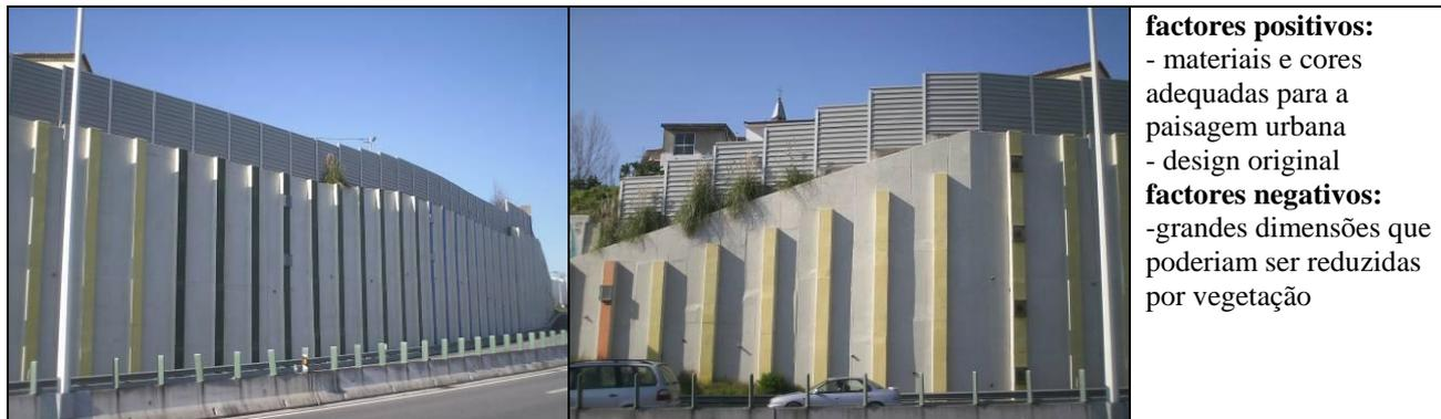
Figura n 4 – Exemplo de Barreiras Acústicas ao longo da A43-IC29
