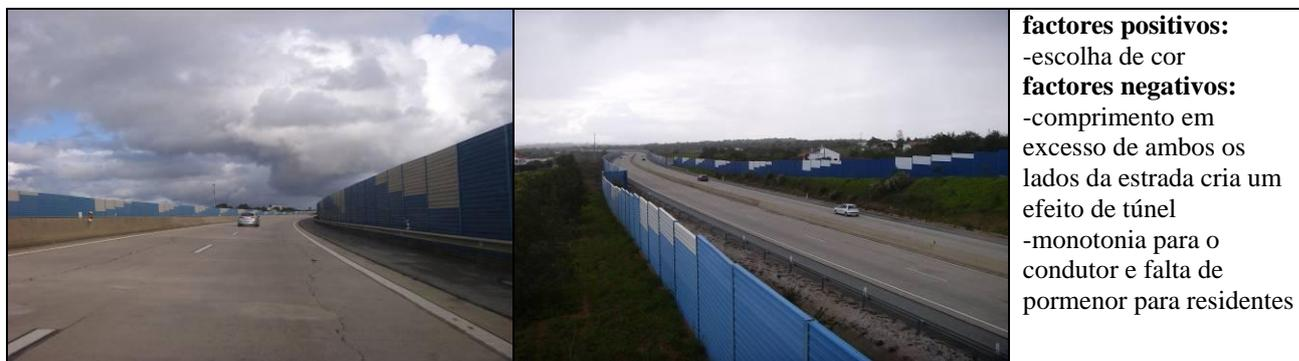
Figura n 3 – Exemplo de Barreira Acústica ao longo da A22-IC4
